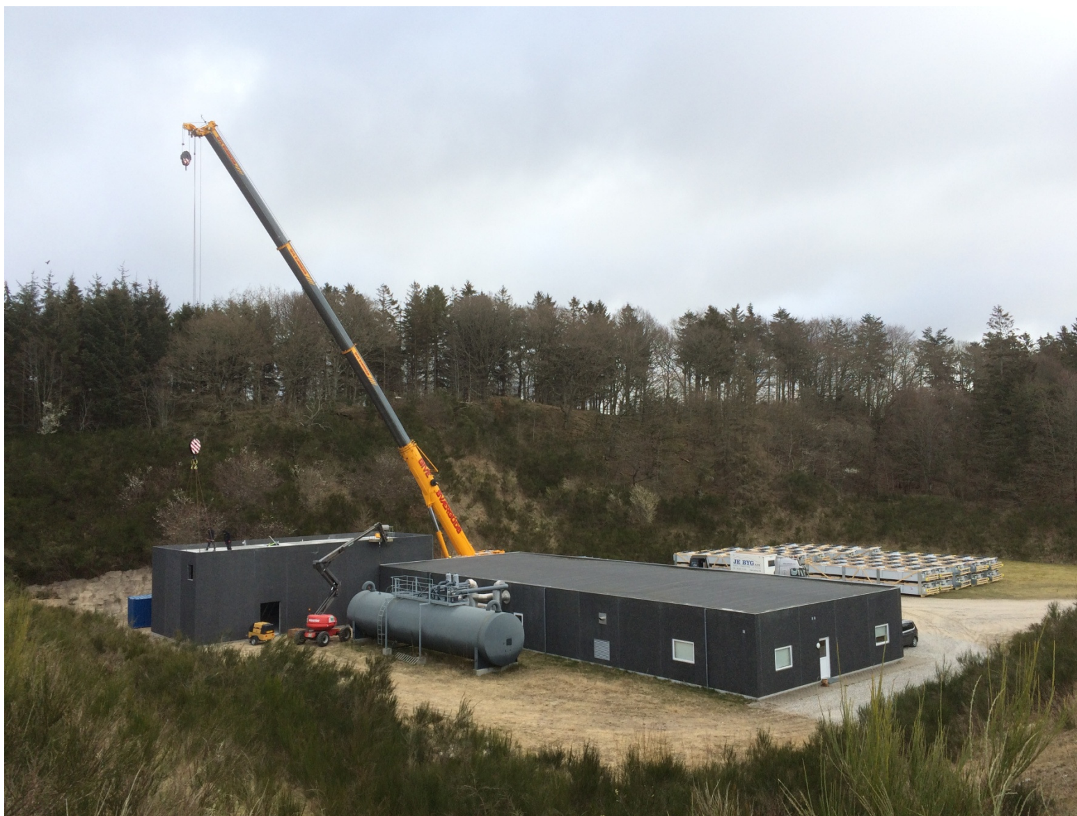
Ny teknikbygning – nord for eksisterende
