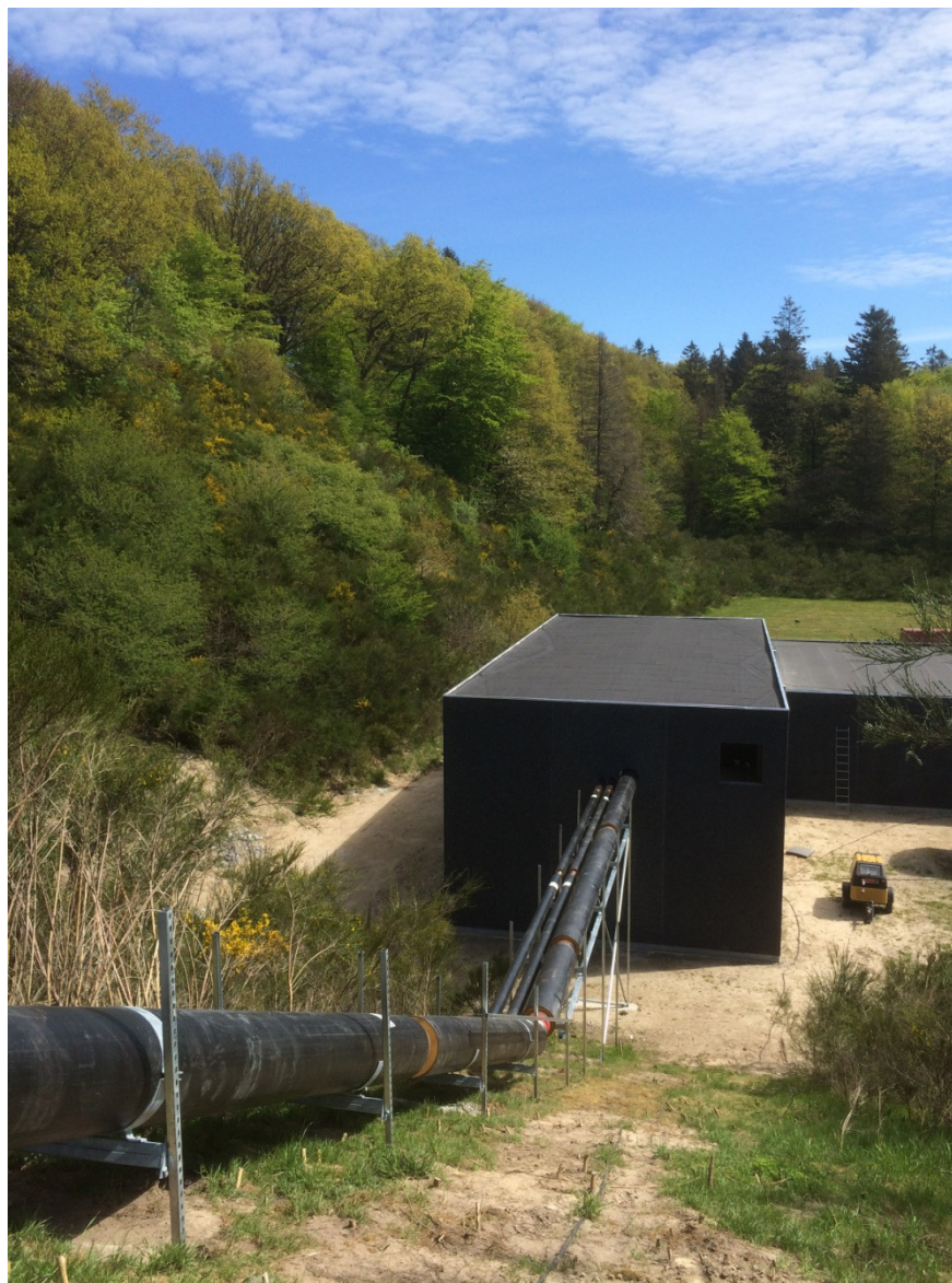
Rørbro ned til "maskinstuen"
