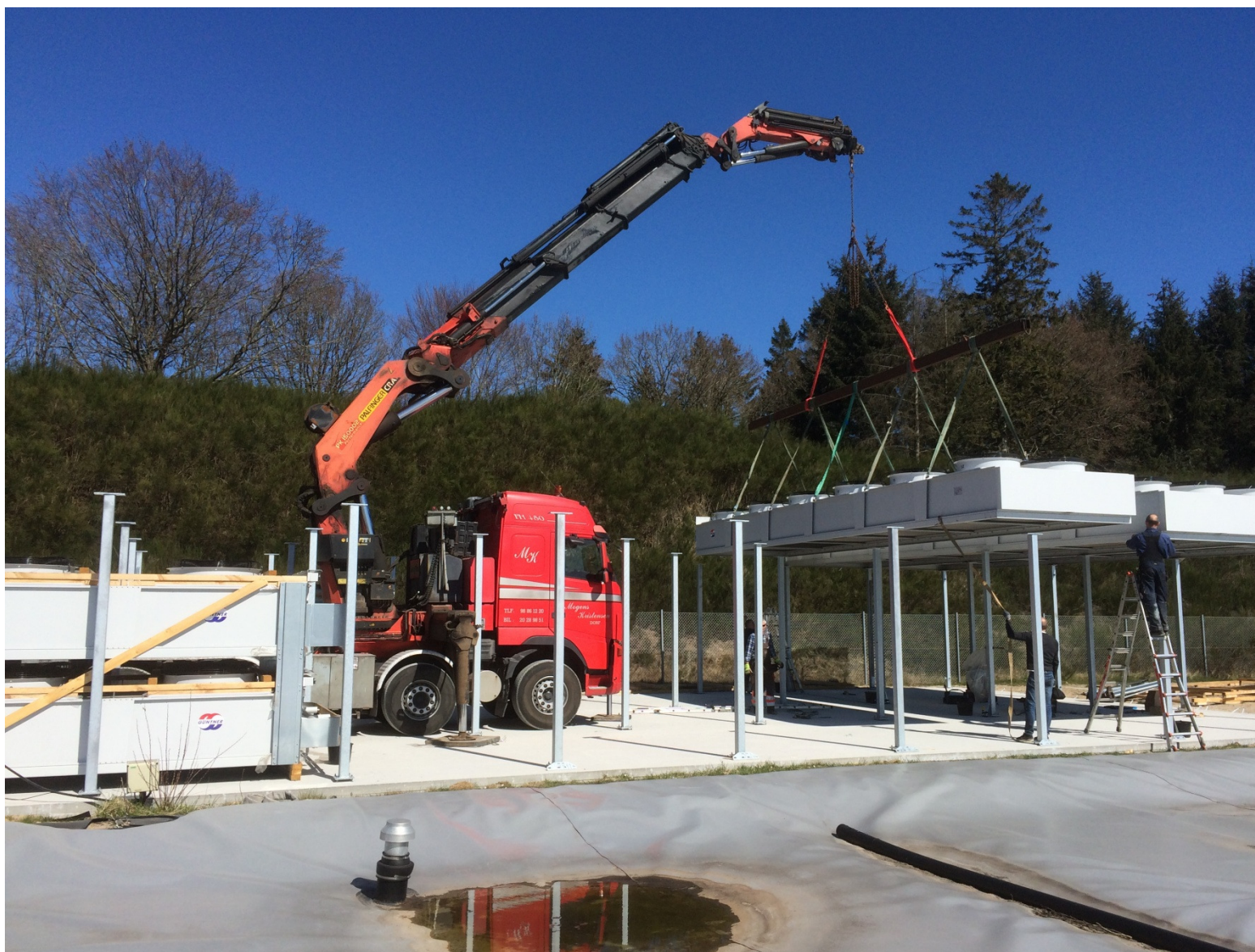
Montering af luftkølere
