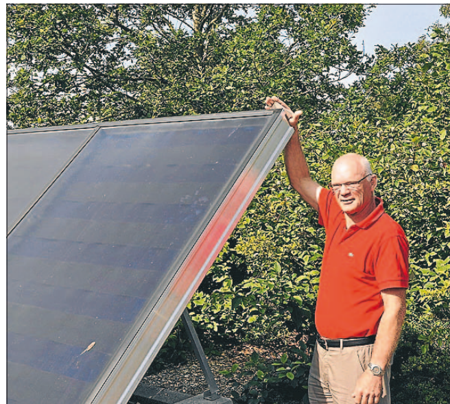
Carsten Møller Nielsen ved det solpanel, som er opstillet på parkeringspladsen foran Dronninglund Fjernvarme. Der, hvor han holder hånden ved udgangsøret, har man tidligere målt en temperatur på 144 grader, og så vender panelet ikke engang nod syd, som panelerne i projektet vil gøre
