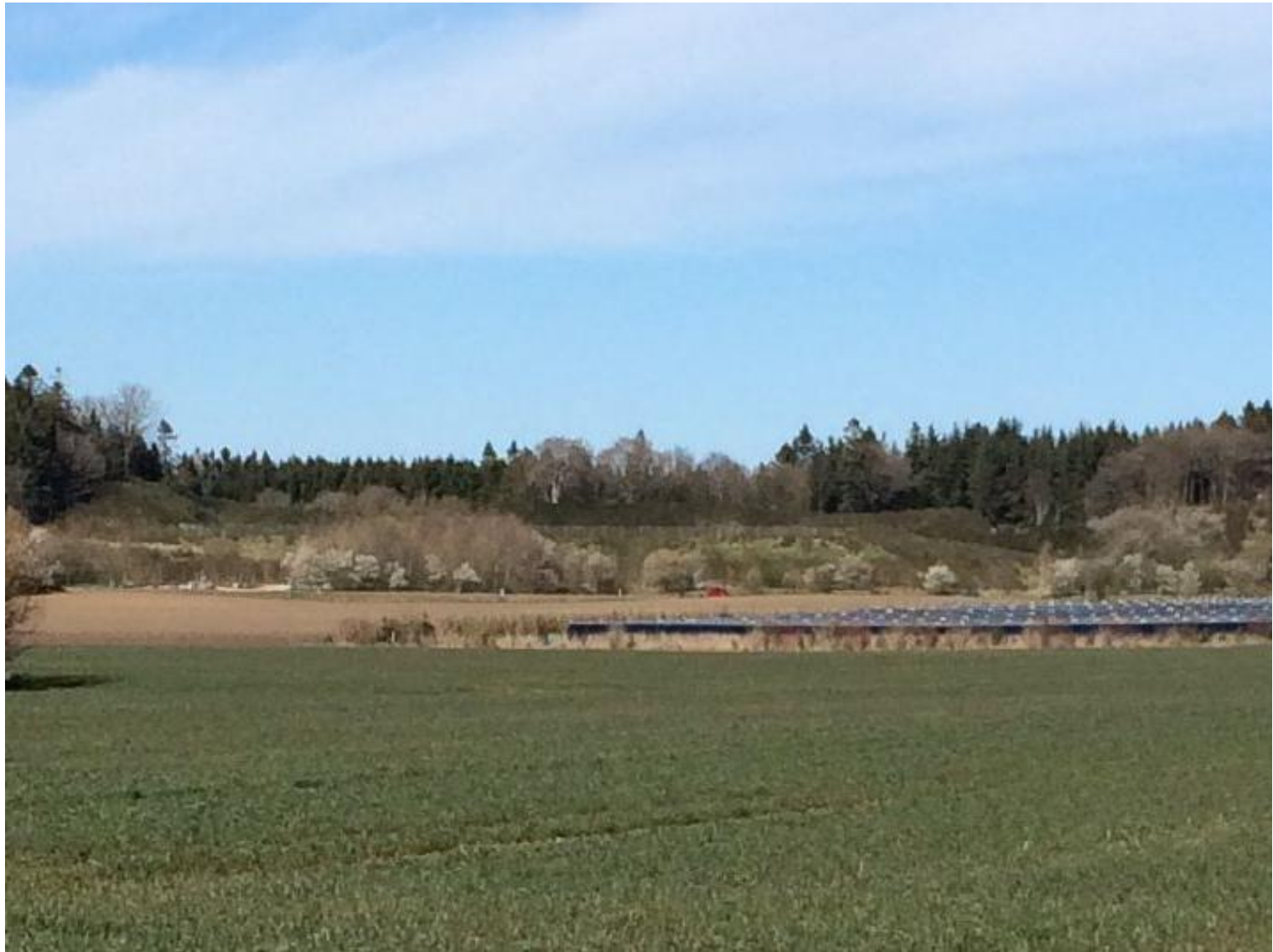
Solfangeranlæg og damvarmelager set fra syd
